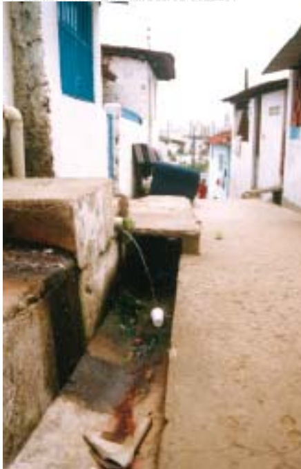
ÁGUAS SERVIDAS LANÇADAS em CANALETA
